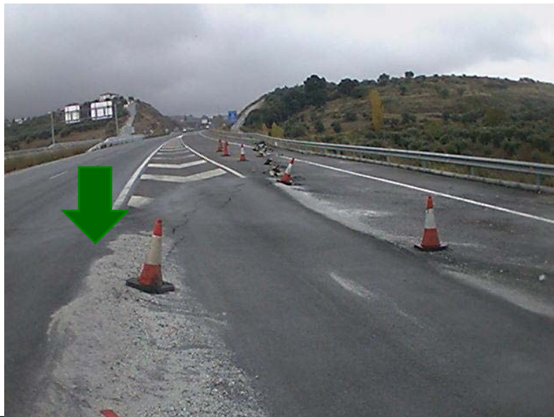
Estabilización de taludes mediante pilotes
