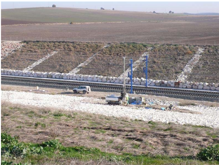
Estabilización de taludes mediante pilotes
